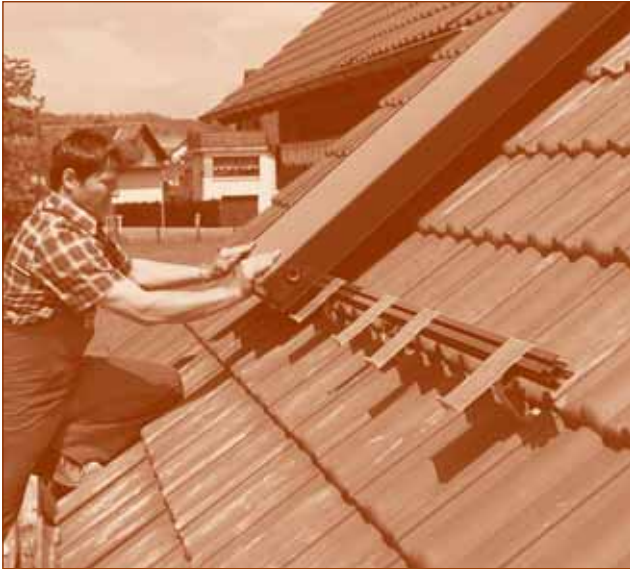
Met frame op een schuin dak
