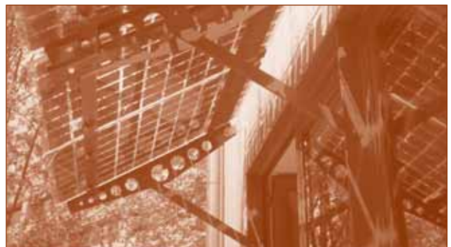
Semitransparante PV-modules als vaste zonnewering (Imec)
