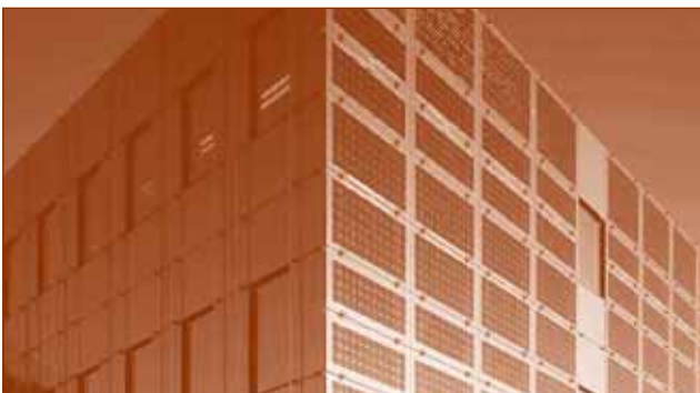
Gevelbekleding met PV-modules op een kantoorgebouw (bedrijf Peiniger, Gelsenkirchen Duitsland)
