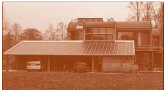
Amorfe PV-film geïntegreerd op metalen dakbanen met staande naad op privéwoningen te Groenlo, Nederland (Bekaert BESS-Europe)
