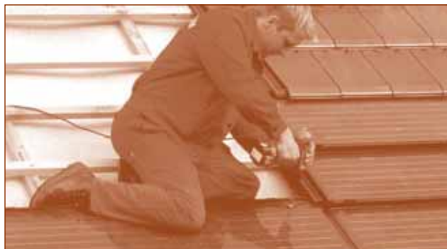
Integratie van PV-shingle voor tegelpanen (Lafarge Braas)
