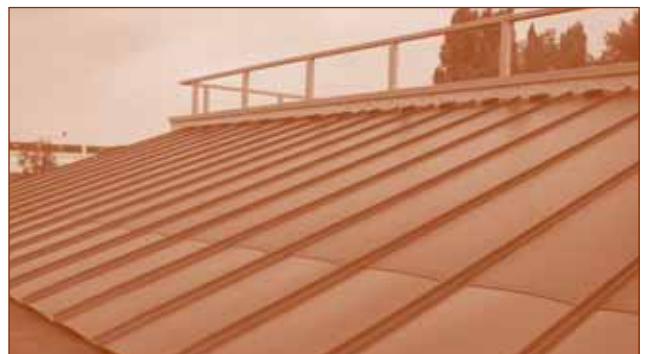
Amorfe PV-film geïntegreerd op metalen dakbanen met staande naad op onderzoekscenrum Bekaert te Zwevegem (Bekaert BESS-Europe)
